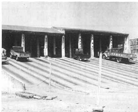
「ブレーキ坂」(制動坂路)の急斜面を使用したブレーキ検査：東京の品川検査場(昭和20年代)
