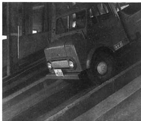
「ブレーキ坂」(制動坂路)の急斜面を使用したブレーキ検査：東京の品川検査場(昭和20年代)
