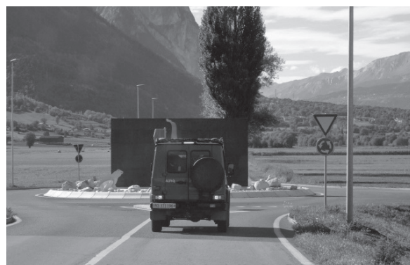
ヨーロッパ郊外部の一般的なラウンドアバウトの例（スイス）。手前から道路案内標識がある。郊外部のため横断歩道はない
