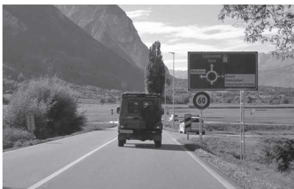
ヨーロッパ郊外部の一般的なラウンドアバウトの例（スイス）。手前から道路案内標識がある。郊外部のため横断歩道はない
