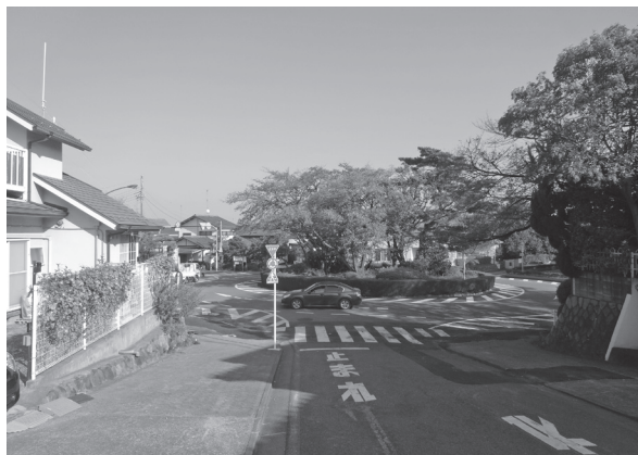
東京都多摩市桜ヶ丘に設置された環状交差点。横断歩道手前で一時停止が義務づけられている。その他はヨーロッパのラウンドアバウトとほぼ同じ
