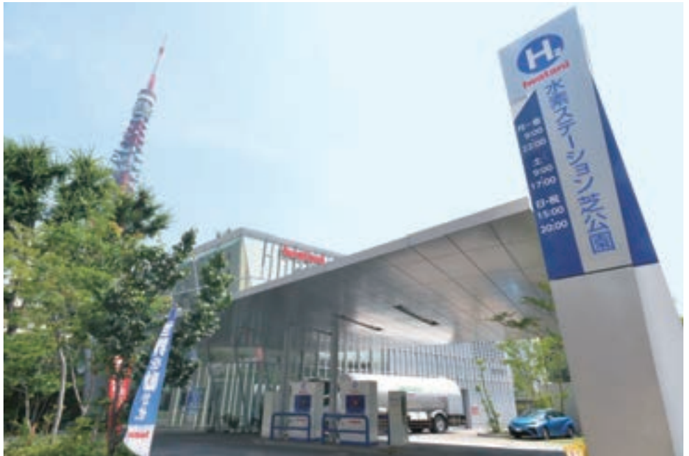
水素ステーション
