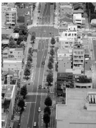
バスレーンの走行環境整備
