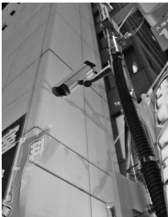
図1 防犯カメラの角度にも気を配る
