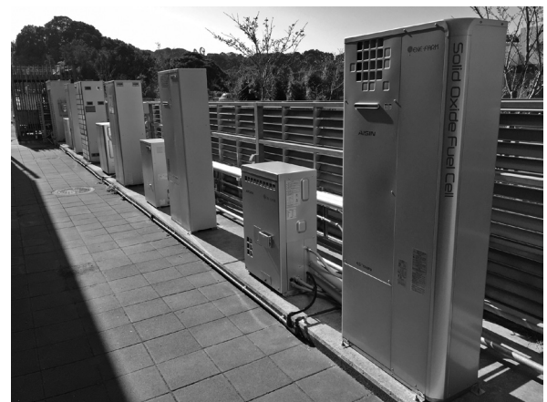
図4●各種家庭用燃料電池「エネファーム」(パナソニック、東芝燃料電池システム、アイシン精機、JX日鉱日石エネルギーの各社製、九州大学伊都キャンパス設置)
