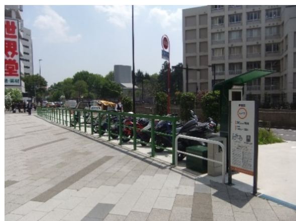
道路占用物件として設置された路外駐車場（新宿区）
