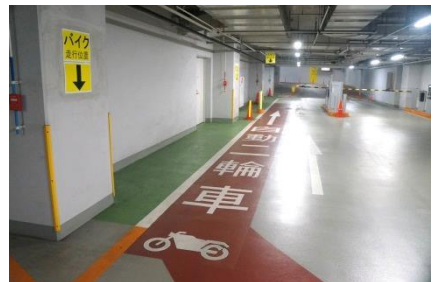
【工夫】 自動二輪車の走行レーンを赤いペイントで視覚化し、入庫から退出までわかりやすく案内表示している。場内の事故防止にも効果が期待できる。
