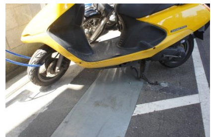
【工夫】駐車スペースはアスファルト舗装だが、スタンド部分に鉄板を敷き渡している。
