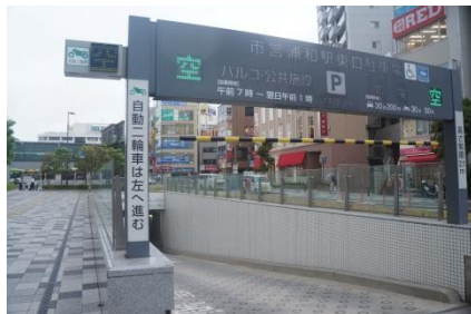
【設置場所】 駅東口に面した地下式自動車駐車場に自動二輪車を収容。入り口には自動二輪車のマークが掲げてあり、満空情報も一目でわかる。
