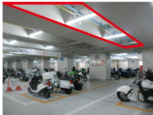
消火設備の設置（赤枠部分）／吹田市
