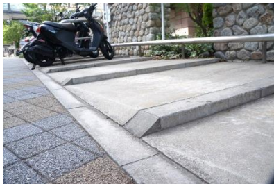
【工夫・設備】 勾配のある道路に駐車枠を設けるため、水平をとったコンクリートで段差をつけている。
