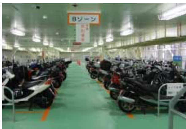
自転車駐輪場との併用（２） 兵庫県明石市 財団法人自転車駐車場整備センターが管理している駅前の市立駐輪場。大型の自動二輪も駐車できる近代的な施設（自走式立体駐輪場）。
