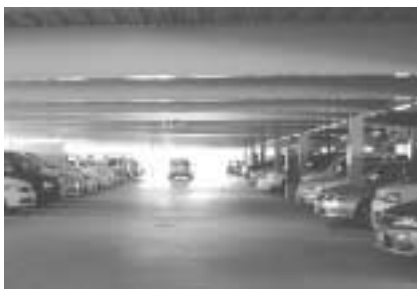
自動車駐車場 二輪車を受け入れるケースは少ない
